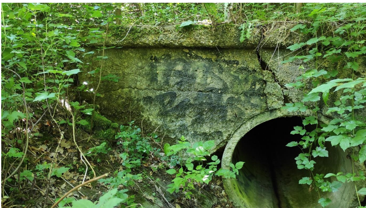
Stávající propustek, kolmé čelo
