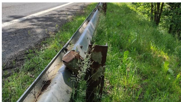
Poškozená svodidla
