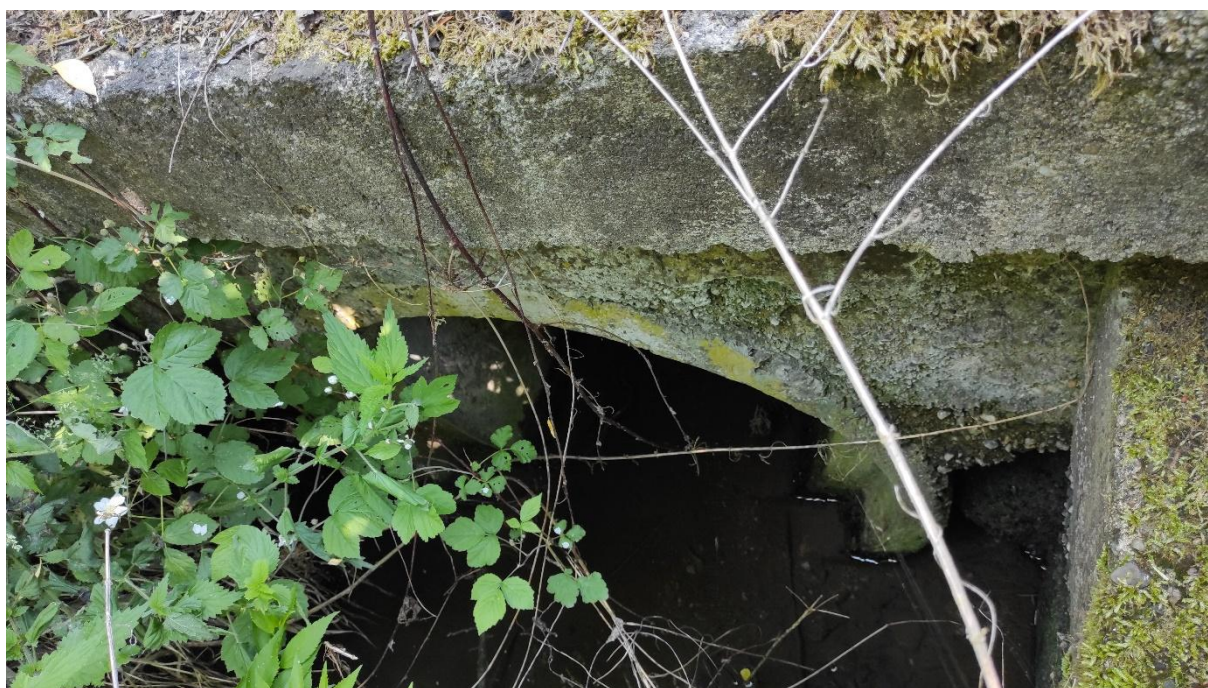
Zanesená jímka propustku
