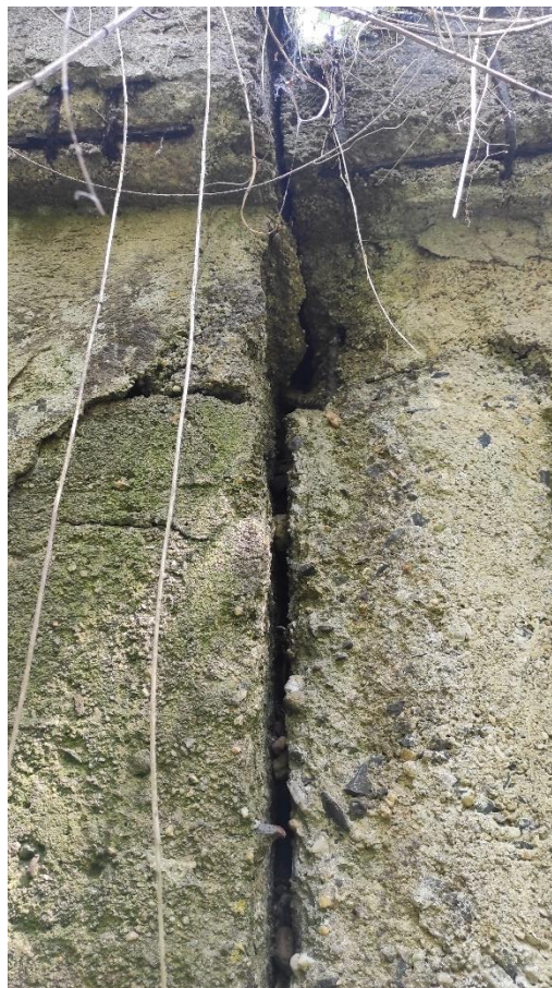
Detail svislé trhliny
