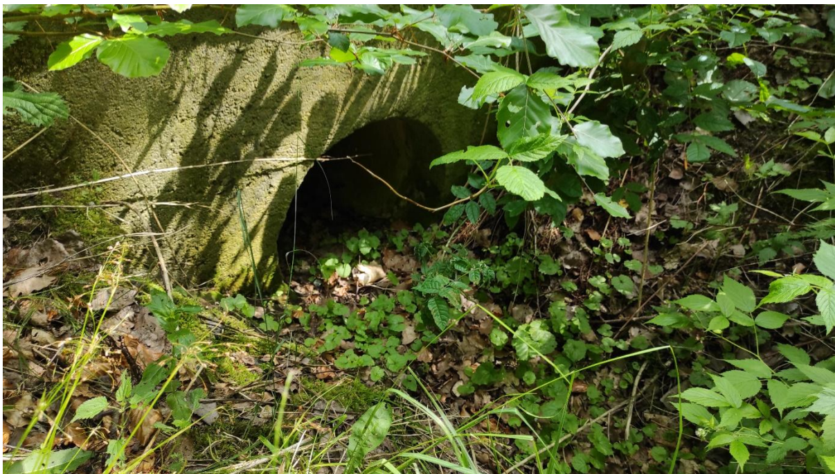
Zanesený propustek
