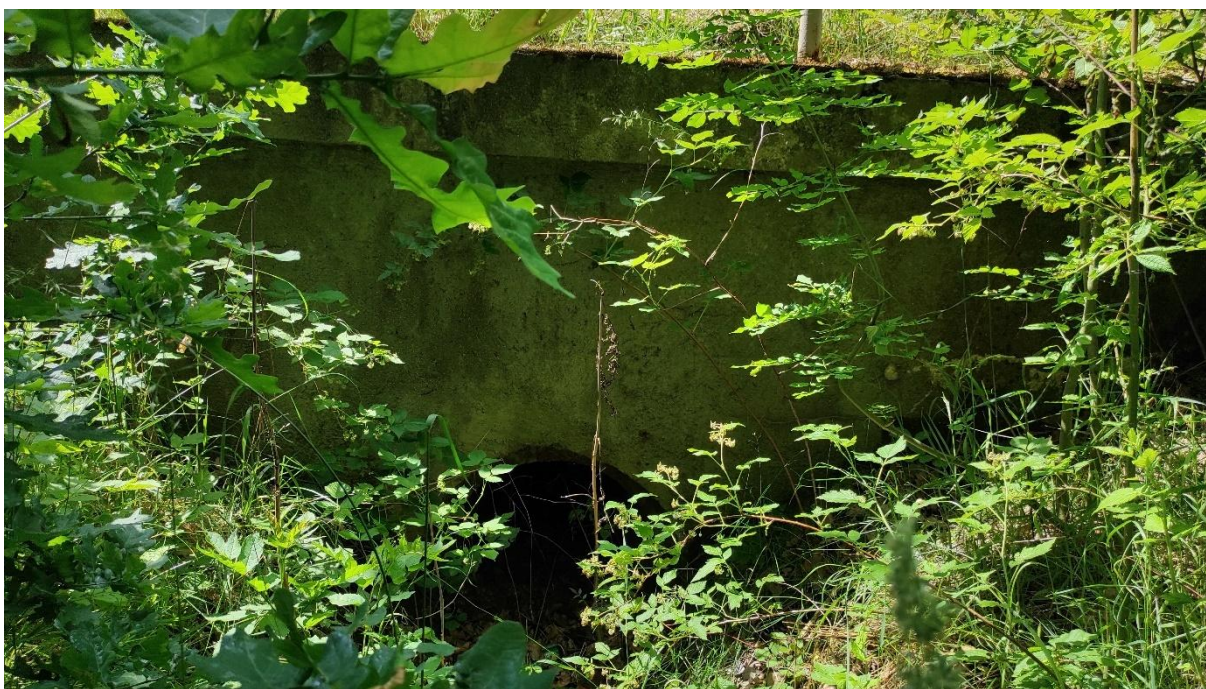
Propustek s kolmým čelem
