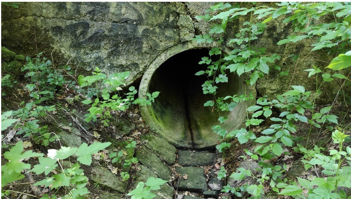
Zpevněné dno propustku
