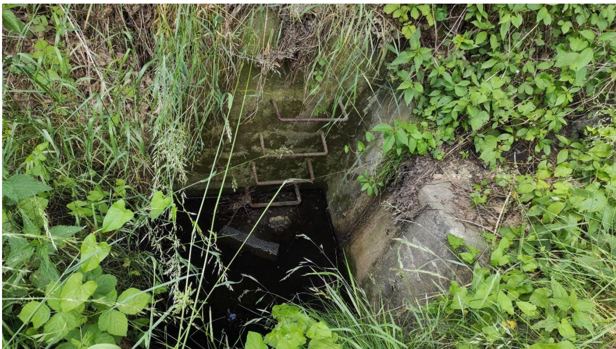
Stávající jímka s propustkem
